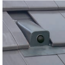
Einbaubeispiel RDF Typ Ton bei Großflächenziegel
